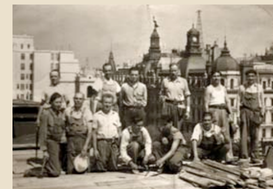
Costruzione del Banco Hipotecario Nacional / Construcción del Banco Hipotecario Nacional, Buenos Aires, 1949 (3283)
